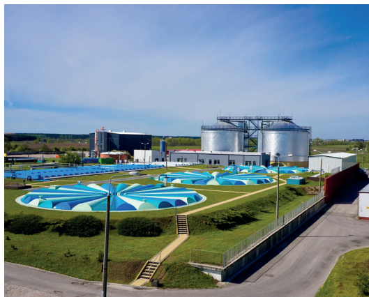
Oczyszczalnia ścieków, fot. z archiwum PWik w Suwałkach Sp. z o. o.
